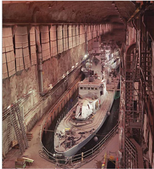
شکل ۲-۱- حفاظت از کشتی جنگی در تونل حفر شده در کوه
